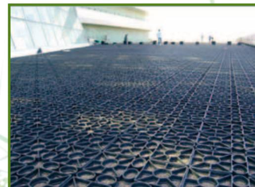
Einfache und schnelle Verlegung der Gitterelemente.
