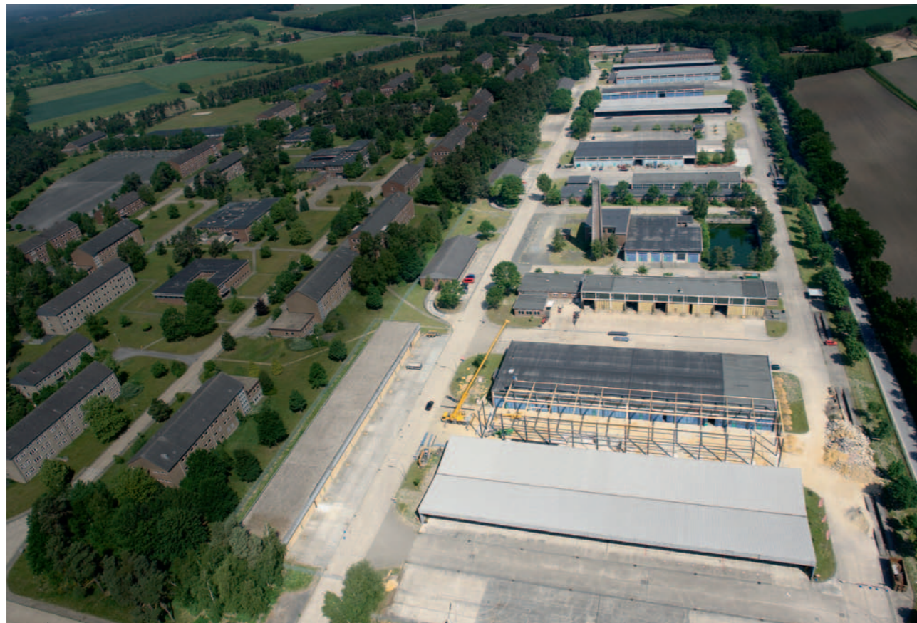
Im Frühjahr 2009 übernahm Krampe Fahrzeugbau den Instandsetzungsbereich der ehemaligen Kaserne Coesfeld-Flamschen. Auf 100.000 m 2 – davon derzeit 28.000 m 2 überdacht – entstand eine moderne und flexible Fertigung.
