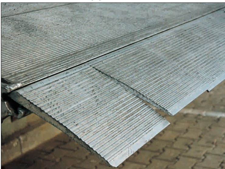
Alu-Auflagerlippe, bestehend aus Einzelsegmenten. Die Verladebrücke paßt sich dadurch an schräggehende LKWs an. ▲
