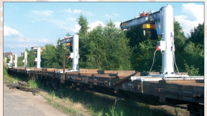
Neun 0,5 t Säulenschwenkkrane auf Spezialrahmen, synchron betrieben mit Zentralfunkfernsteuerung für die Montage von 30 m langen Gleisschienen.
